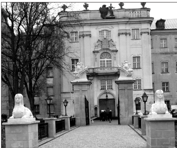
Widok na odrestaurowany most
