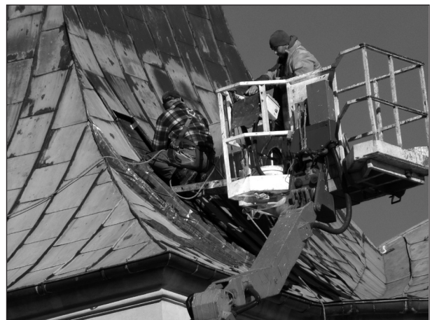
Naprawa zerwanego poszycia baszty północno-zachodniej
