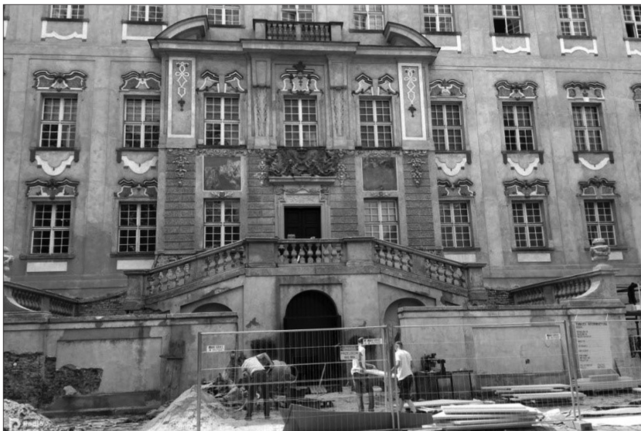
Stan ściany wschodniej Zamku przed wykonaniem prac konserwatorskich
