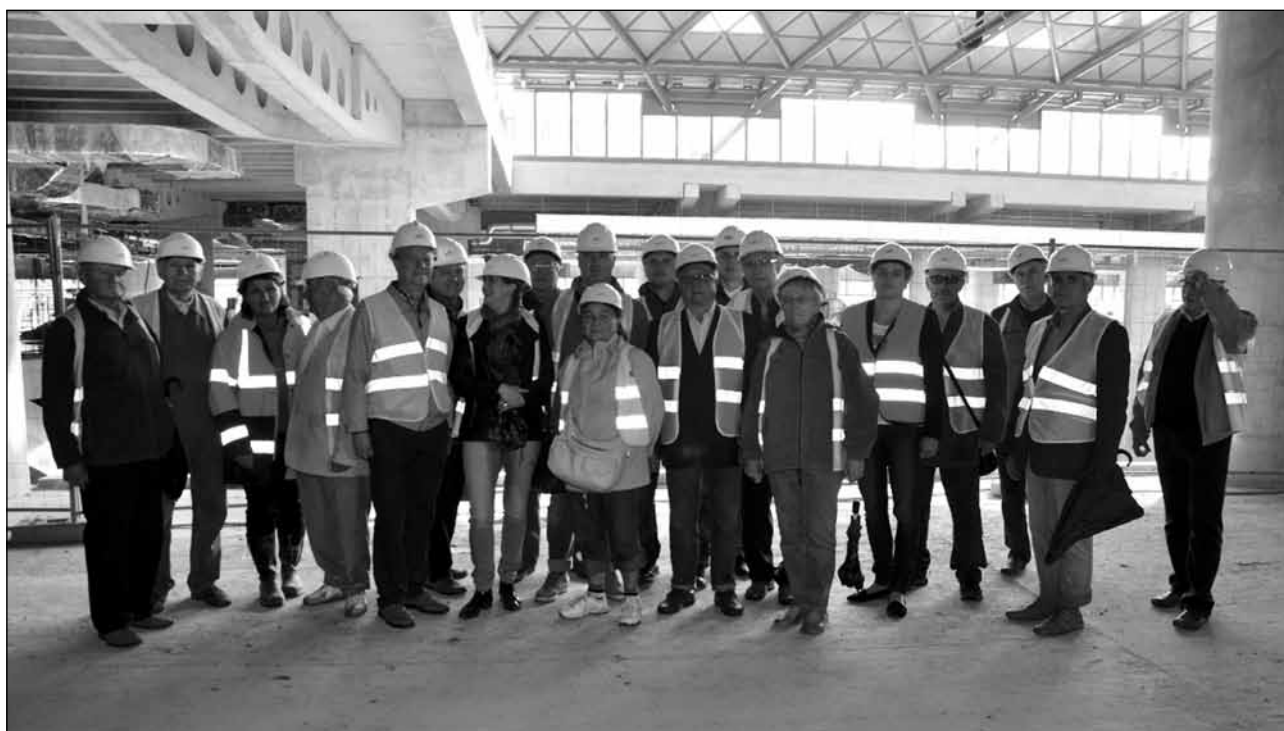
Uczestnicy wycieczki na terenie budowy dworca Łódź Fabryczna
