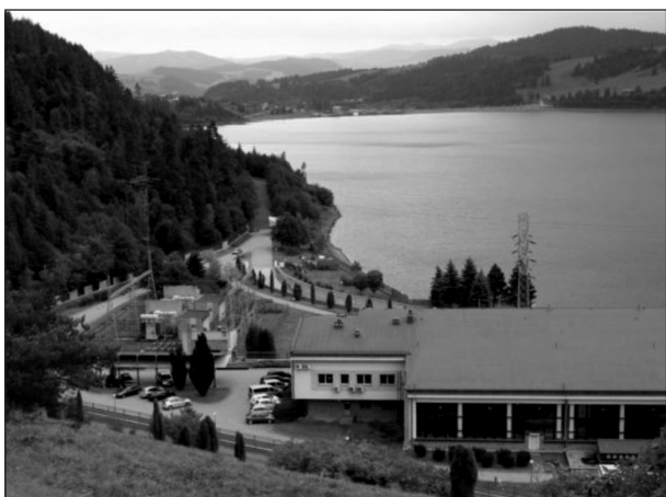
Widok z zapory na elektrownię Niedzica
