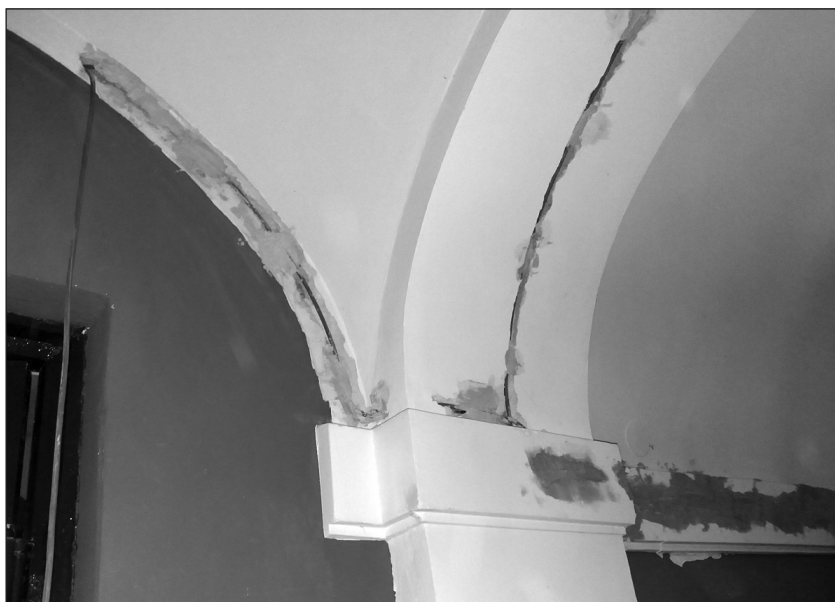
Przykłady prowadzenia instalacji pożarowych
