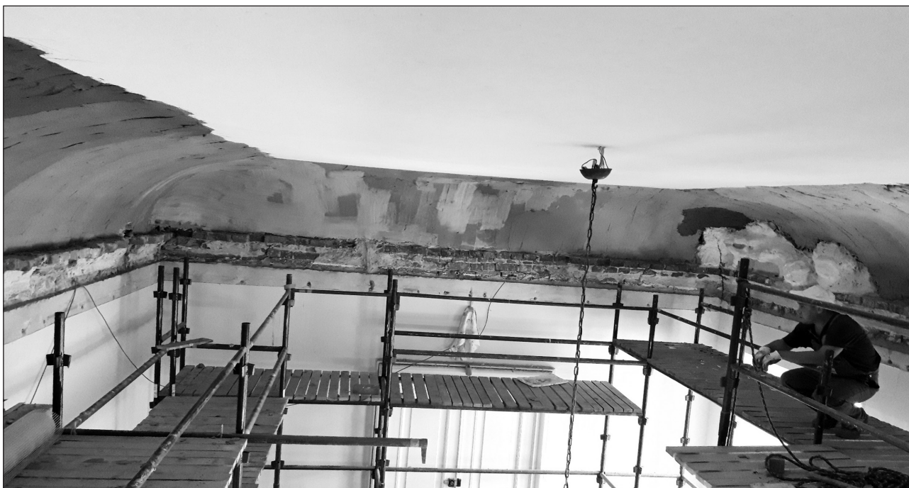
Widok na świeżo wykonane konstrukcje fasety
