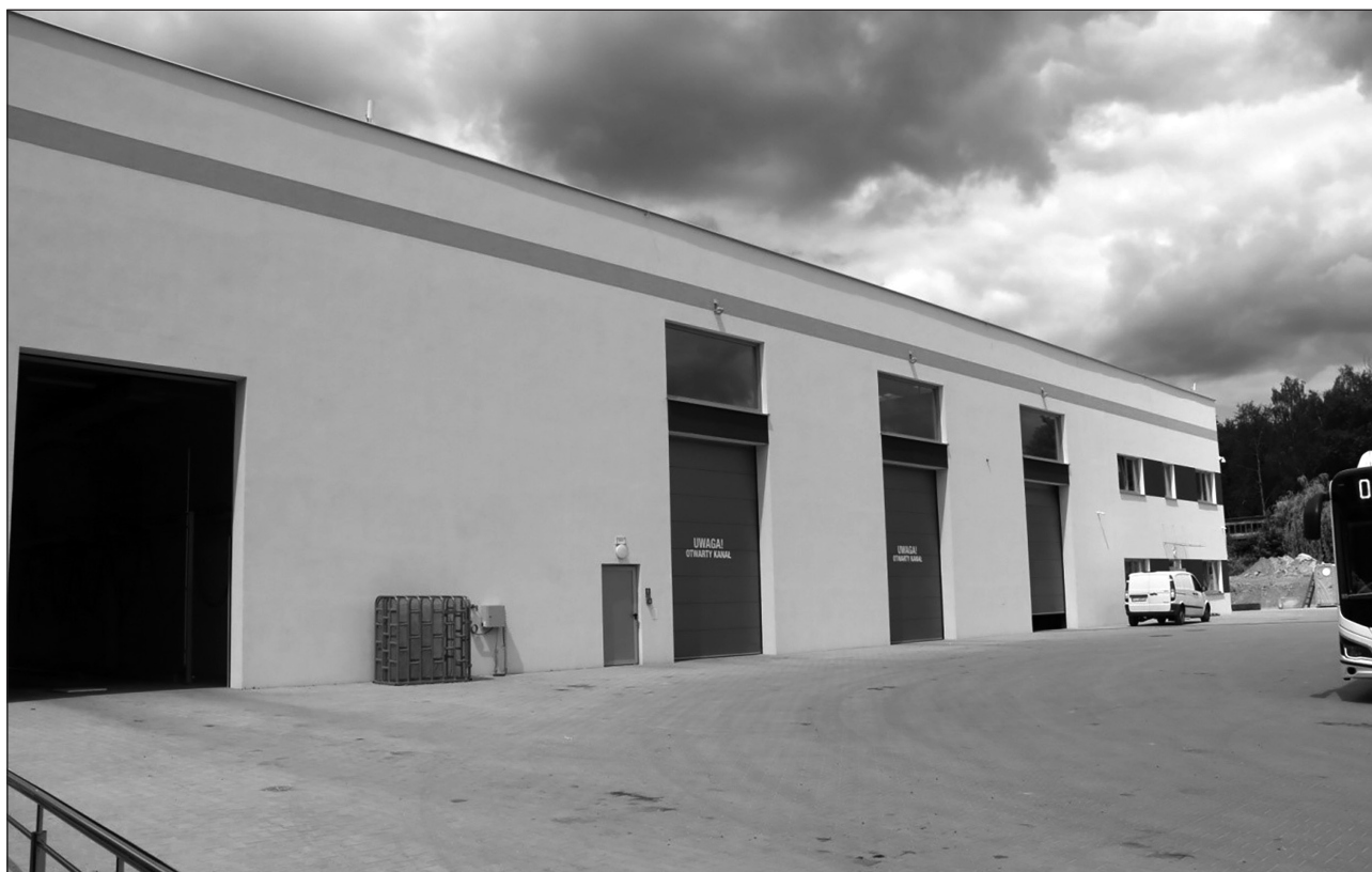
Nowy budynek warsztatowy dla autobusów
