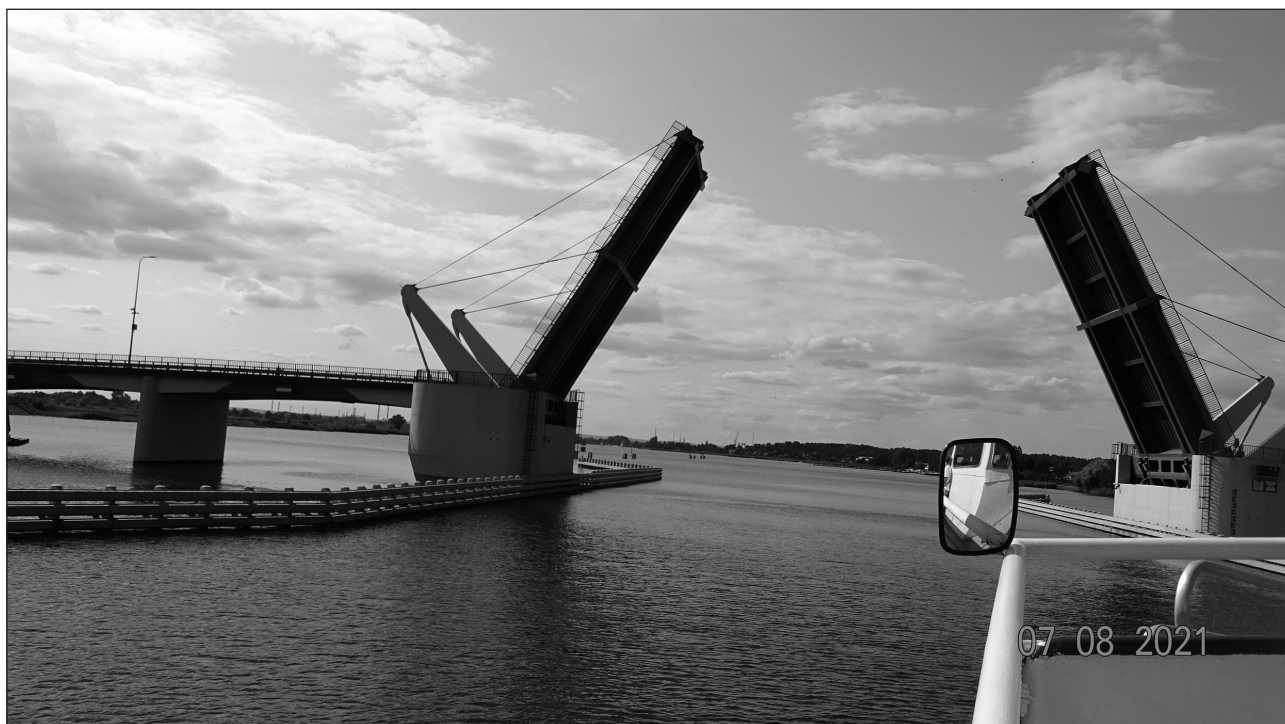
Nowy most na Wyspę Sobieszewską
