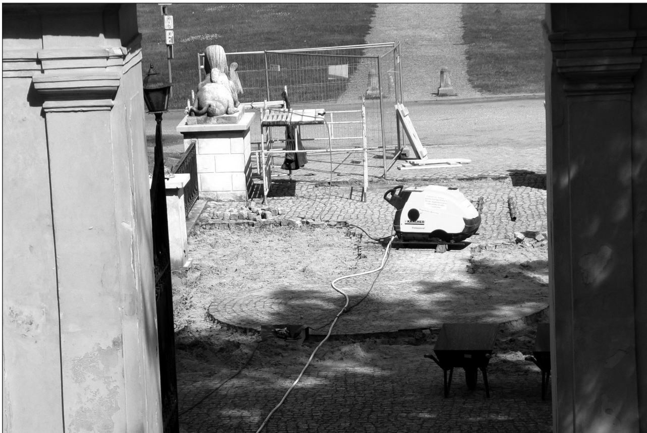
Początek prac na moście – demontaż kostki brukowej
