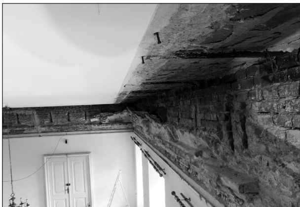
Widok ogólny części podsufitowej
